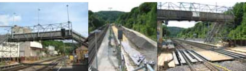
Bauarbeiten im Bahnhof Hartmannshof
